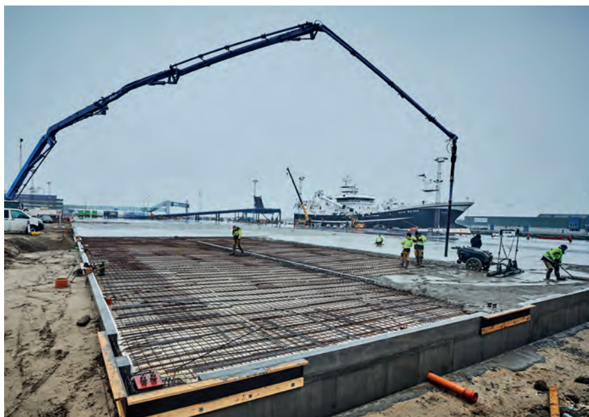
Støbningen af fundament med FUTURECEM cement.
